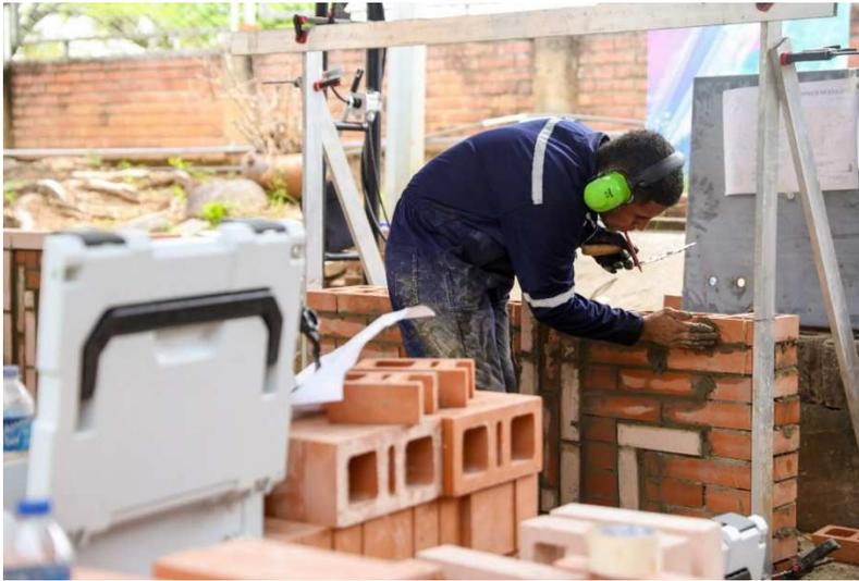
*Ilustración 1. Representación del proceso constructivo de un muro en mampostería (SENA, s.f)*
